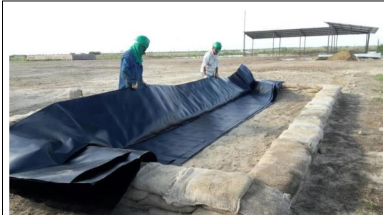
Fotografía 2-6 Dique pruebas auxiliares
