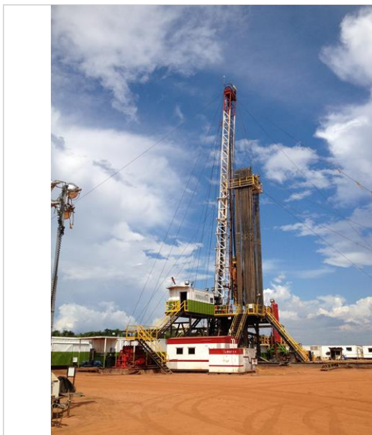
Fotografía 2-7 Taladro de perforación
