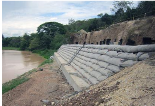
Fotografía 2-2 Ilustración de muro de contención
