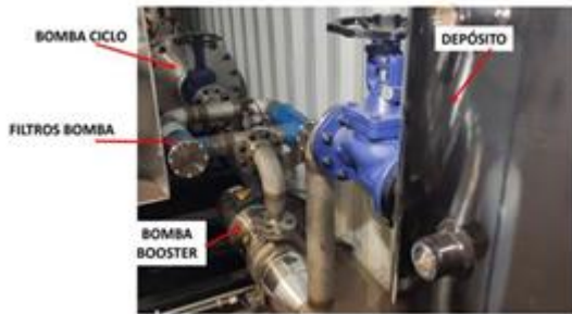
Figura 2-126. Circuito 1, Unidad de Flujo cerrado
