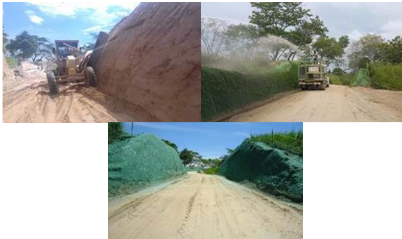
Fotografía 2-1 Revegetalización de taludes
