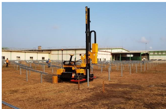
Fotografía 2-21 Máquina para hincado de la estructura de los paneles,
