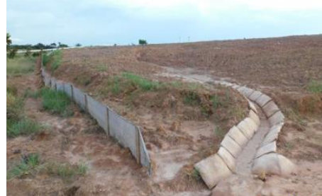
Figura 1. Esquema de cuneta en saco-suelo para manejo de aguas lluvias
